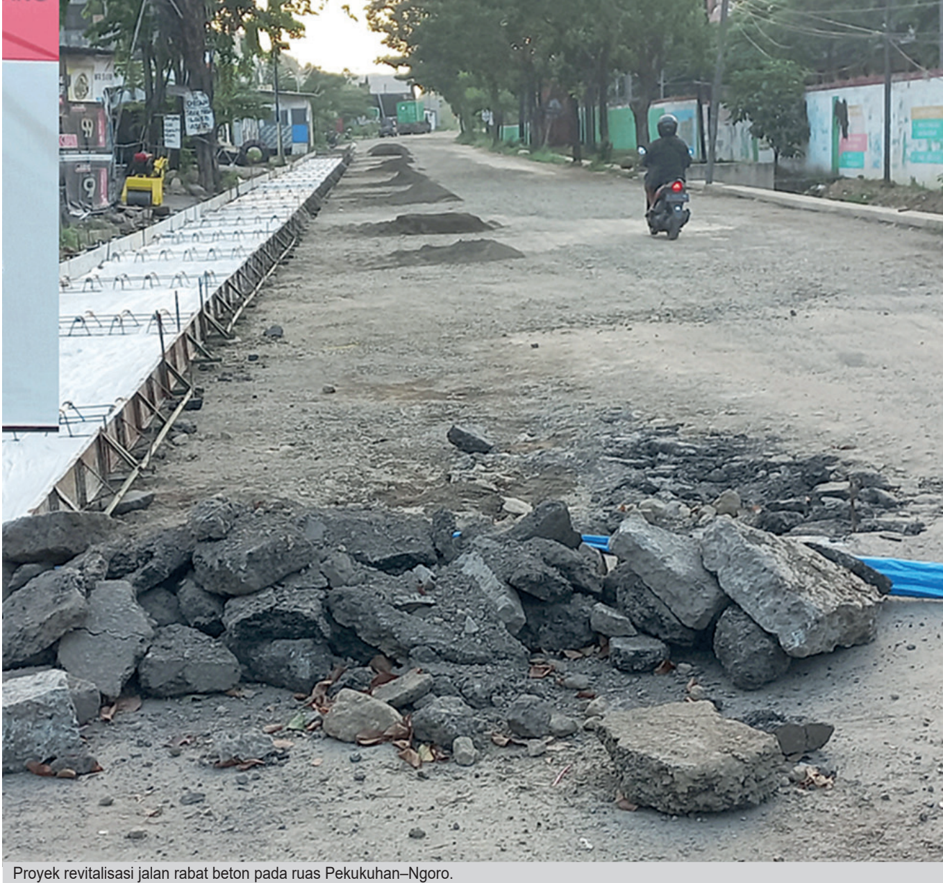
Proyek revitalisasi jalan rabat beton pada ruas Pekukuhan–Ngoro.
