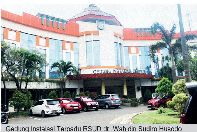
Gedung Instalasi Terpadu RSUD dr. Wahidin Sudiro Husodo Kota Mojokerto.
