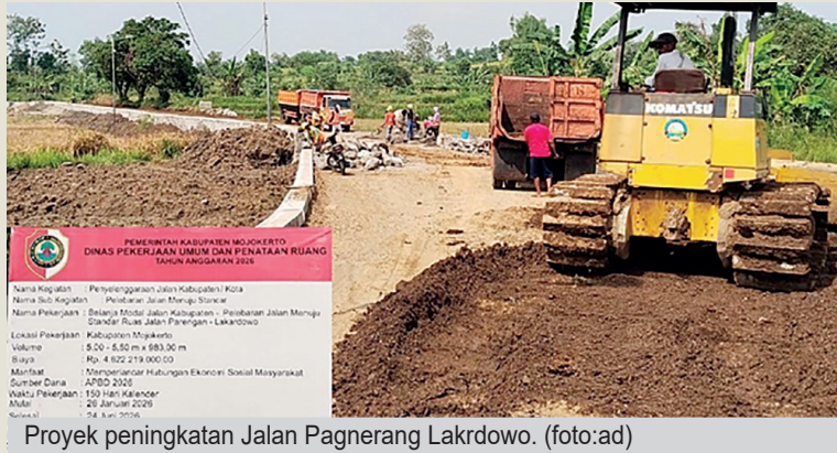
Proyek peningkatan Jalan Pagrerang Lakrdowo. (foto:ad)
