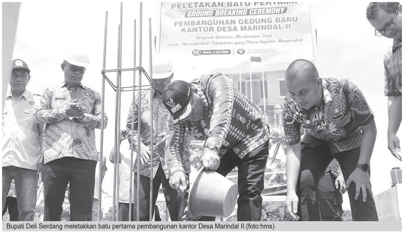
Bupati Deli Serdang meletakkan batu pertama pembangunan kantor Desa Marindal II. (foto:hms)
