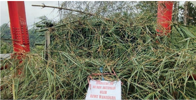
Penutupan jembatan gantung Sukamenak di perbatasan Kabupaten Ciamis dan Kota Tasikmalaya yang ditutup. (Foto:Mamay)
