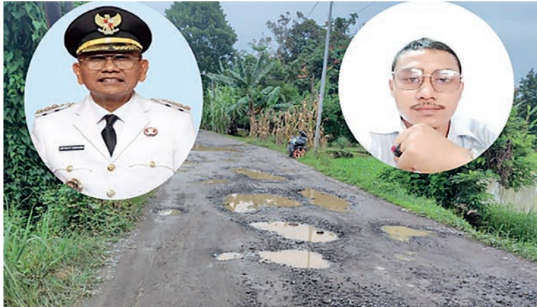
Jalan rusak. (Foto: ist)
