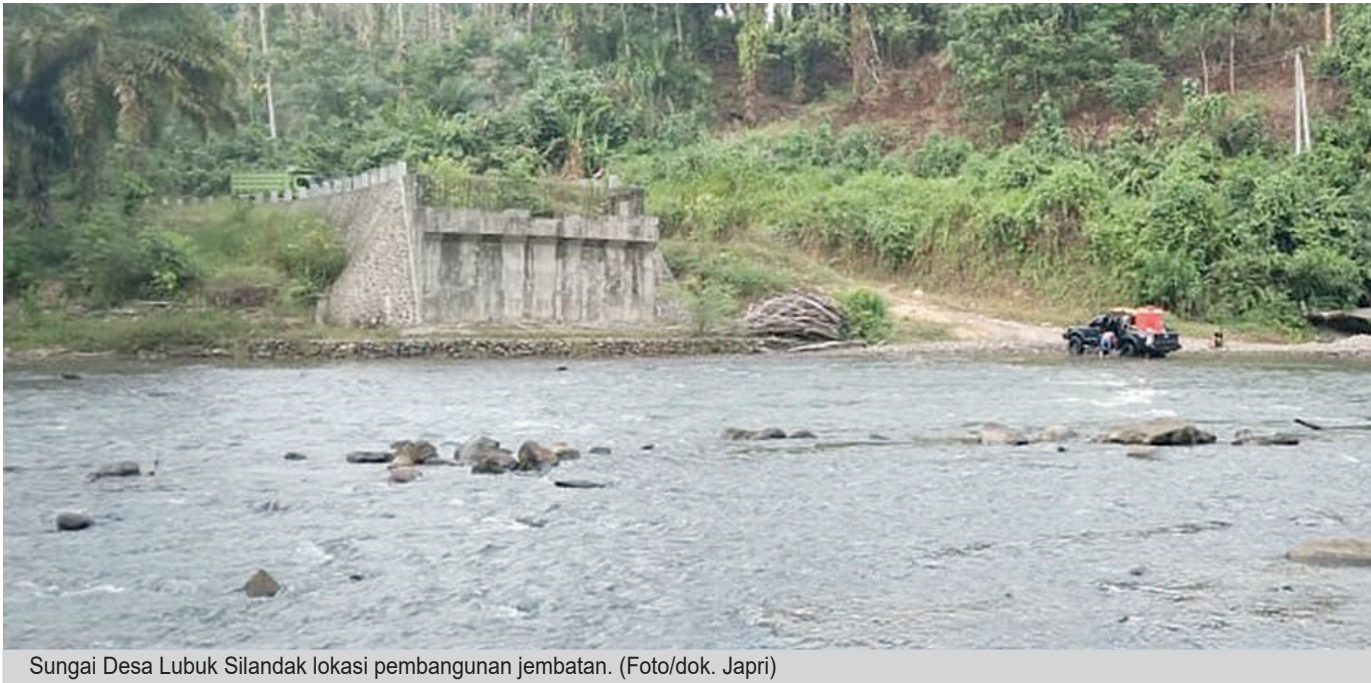
Sungai Desa Lubuk Silandak lokasi pembangunan jembatan. (Foto/dok. Japri)
