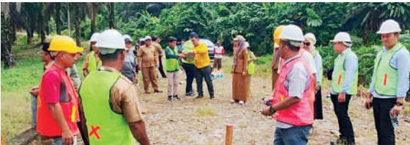
Percepatan pembangunan jembatan Lubuk Silandak butuh dana tambahan. (Foto/Japri)
