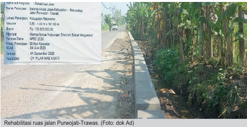
Rehabilitasi ruas jalan Purwojati-Trawas. (Foto: dok Ad)
