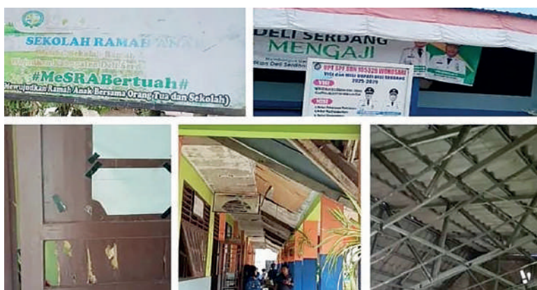
Kondisi saat ini SDN 105329 Wonosari, Kecamatan Tanjung Morawa, Kabupaten Deli Serdang. (Foto/HI)
