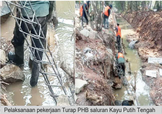
Pelaksanaan pekerjaan Turap PHB saluran Kayu Putih Tengah
