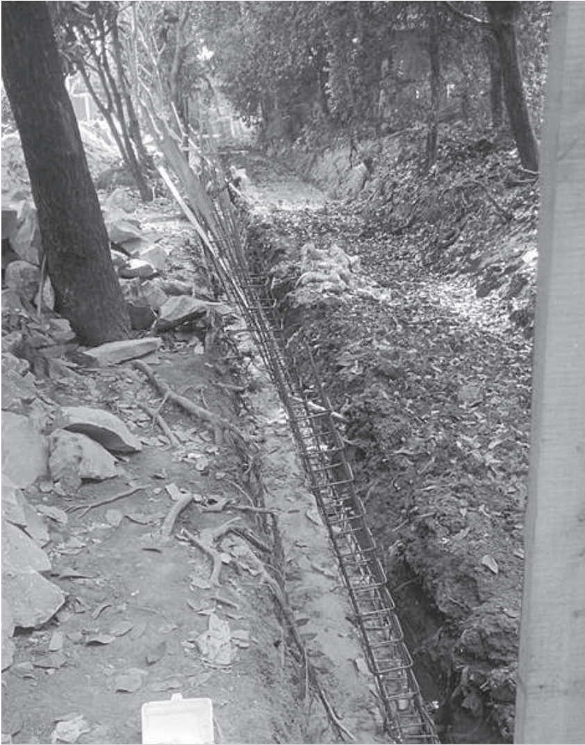
Pekerjaan pemeliharaan turap saluran PHB Cipinang Jaya RW 004, jl. Cipinang Muara KC Jatinegara Jaktim. (Foto/Pur)
