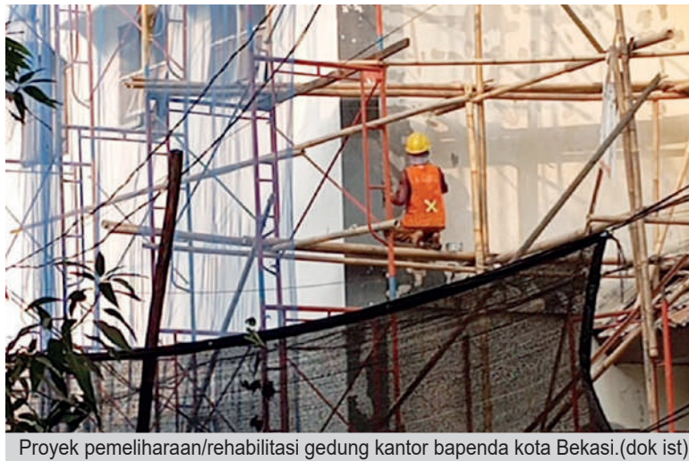
Proyek pemeliharaan/rehabilitasi gedung kantor bapenda kota Bekasi. (dok ist)
