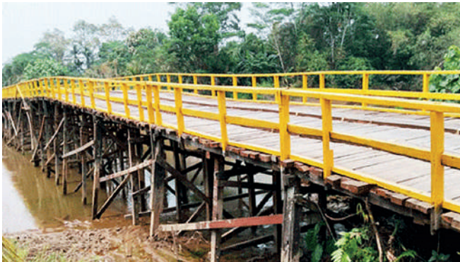
Jembatan Antar Desa di Desa Talio Muara, yang dibangun oleh CV. Garuda Kalimantan Perkasa menelan dana Rp 611.750.000 (Foto dok : japos.co)
